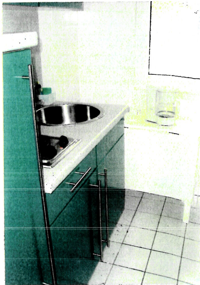
Blick in eine Küche (Haus V – VII)
