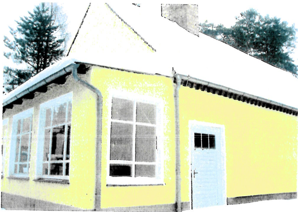
Blick zu Haus III (Heizhaus, Unterkunft)
